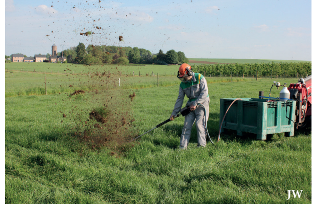
Einspritzen einer explosiven Gasmischung in die Gänge
