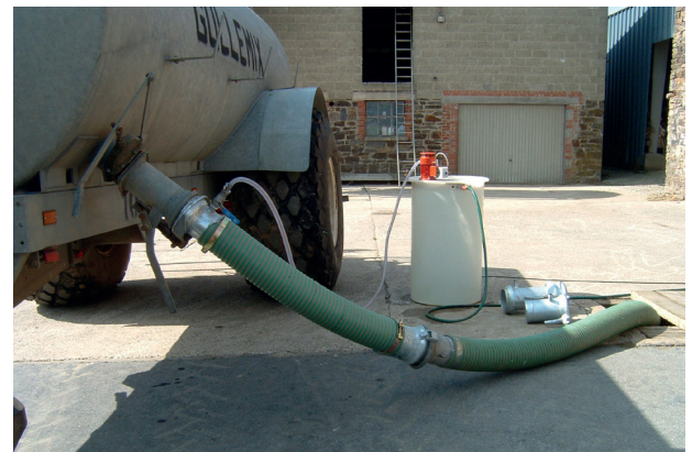
Befüllen des Fasses mit Gülle und der Wasser-Saatgut-Mischung
